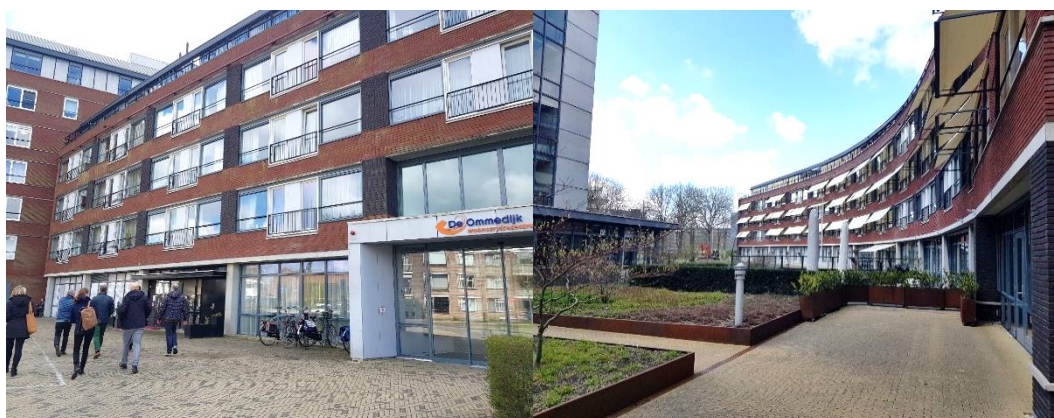
Afbeelding 1.4: Binnenzijde van Woonzorgcomplex De Ommedijk
