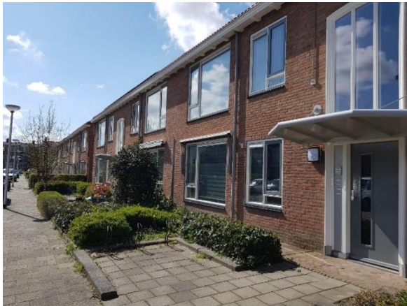
Afbeelding 1.7: Gerenoveerde en verduurzaamde woningen aan de Pinksterbloem
