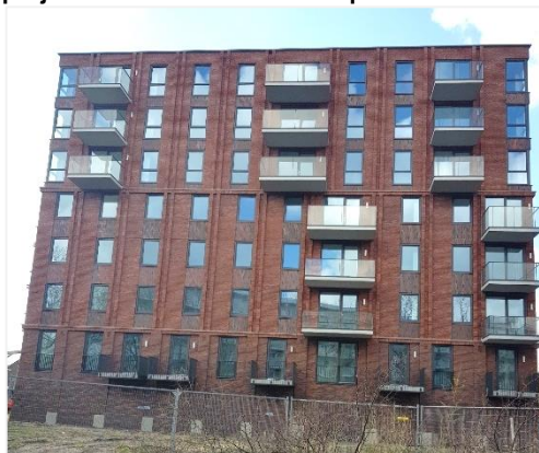
Afbeelding 1.1: Bijna opgeleverde nieuwbouw- project van 49 sociale huurwoningen in het project Driemaster in Leiderdorp
